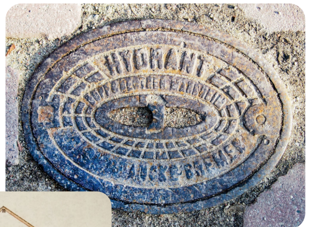
Zachowana do dziś pokrywa hydrantu firmy Bopp&Reuther z Mannheim. Fot. Adam Płoski
